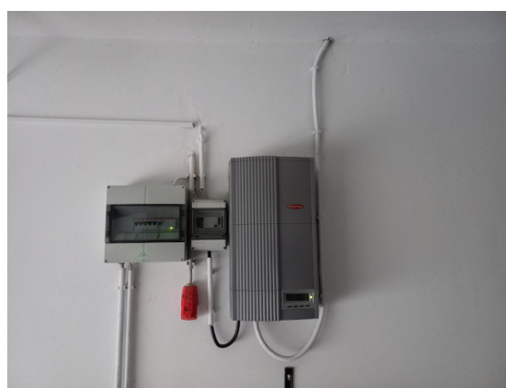
Wechselrichter, FI-Sicherung
